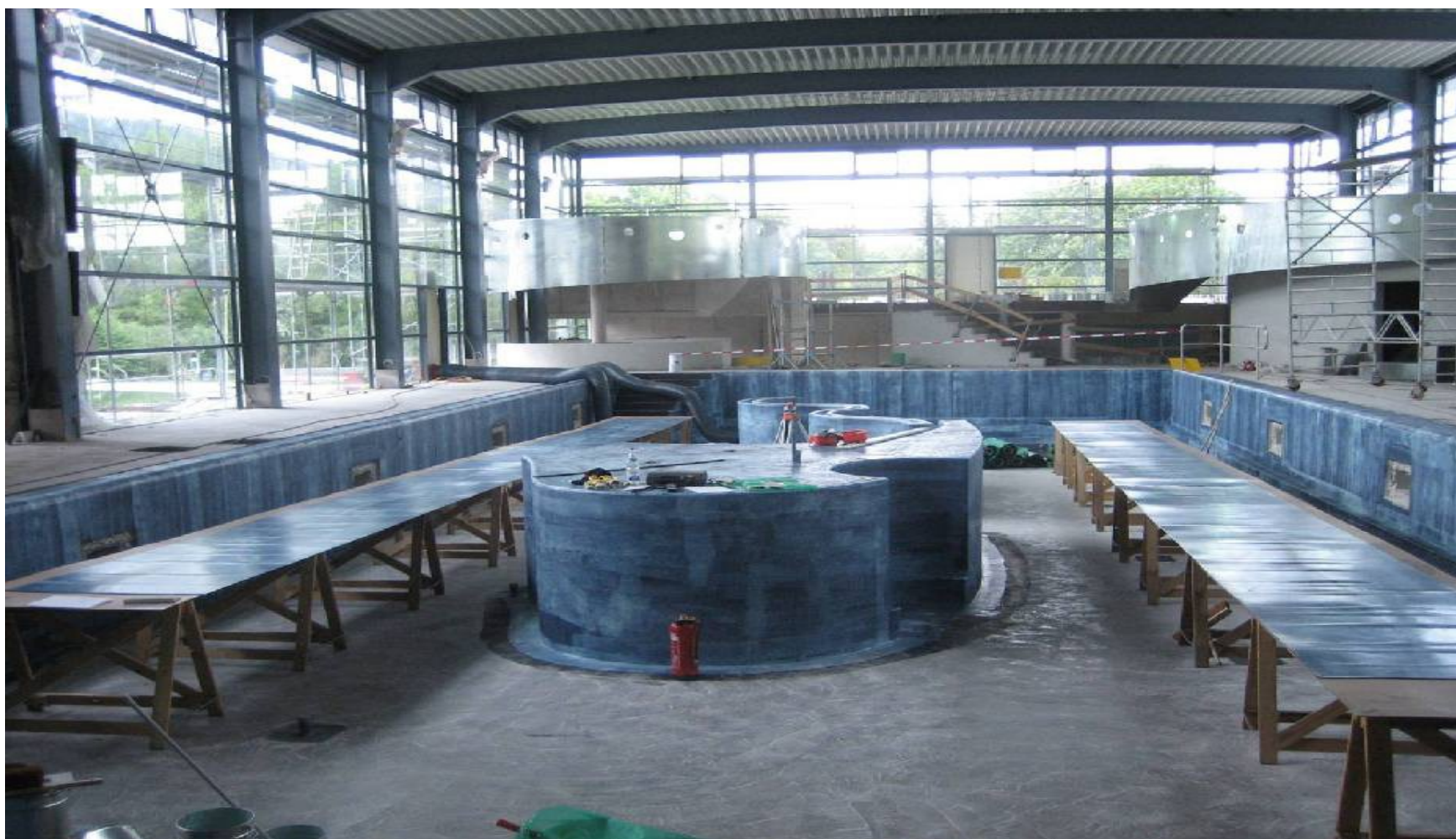
PRZYGOTOWANE PODŁOŻA POD APLIKACJĘ POWŁOKI GUMOWEJ
